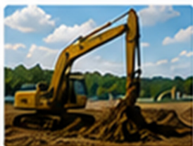
建設・土木現場
